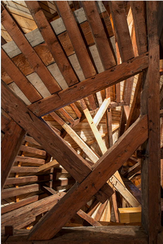
Enrayure nord-est de la charpente du dôme.
