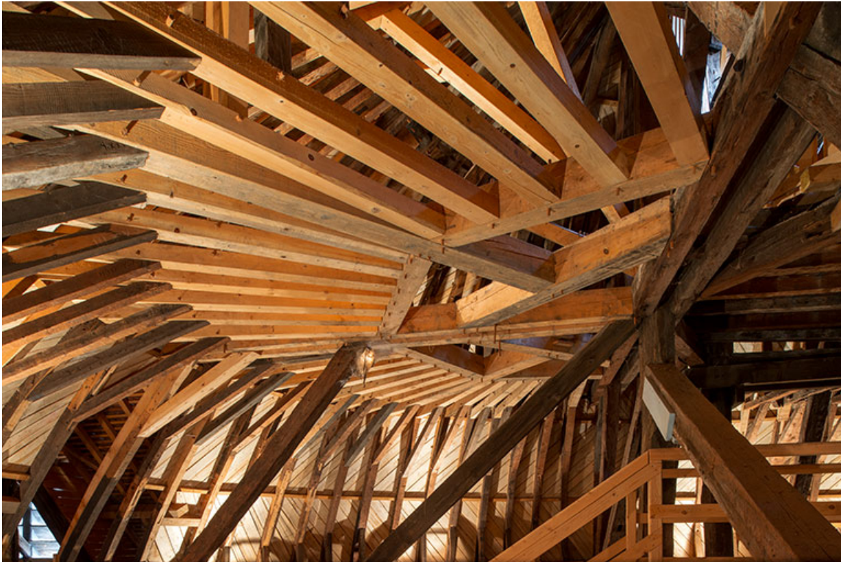
Enrayure du côté occidentale, depuis le sud.
