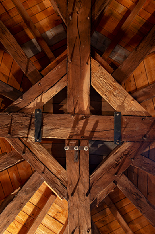
Charpente du dôme. Enrayure centrale.
