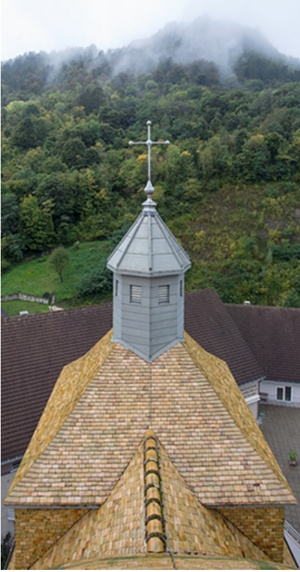
Toiture de la sacristie, depuis le lanterneau.
