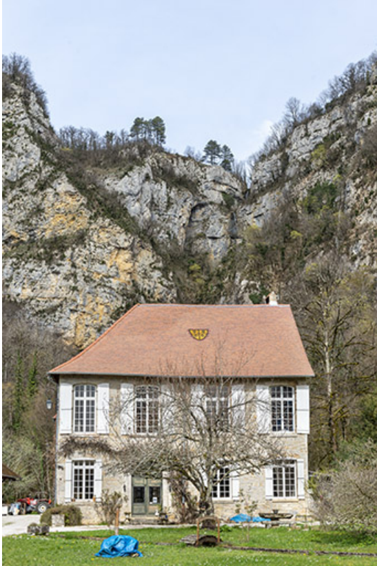
Façade sud du logis abbatial (cadrage vertical).
