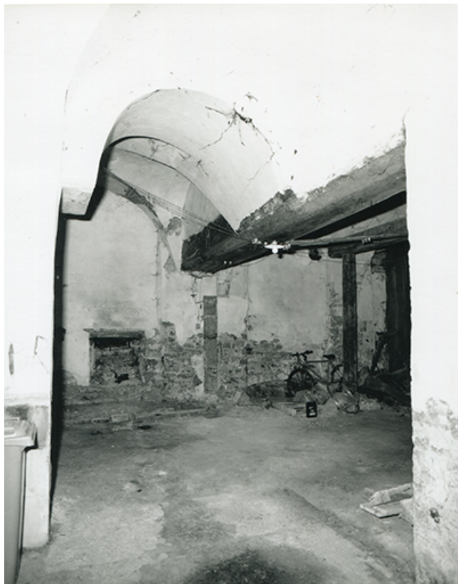
Rez-de-chaussée du bâtiment conventuel, 1997.
