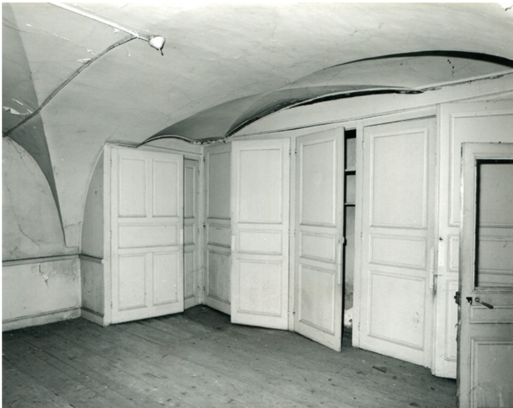
Rez-de-chaussée du bâtiment conventuel. Pièce côté sud, 1997.
