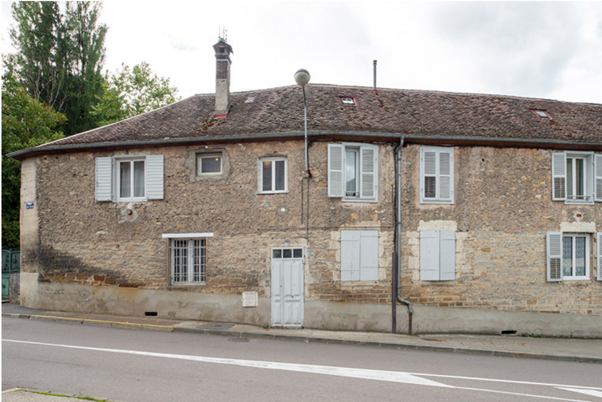
Extrémité est des bâtiments conventuels. Façade nord.
