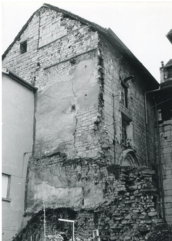
Mur-pignon ouest de la chapelle, 1990.
