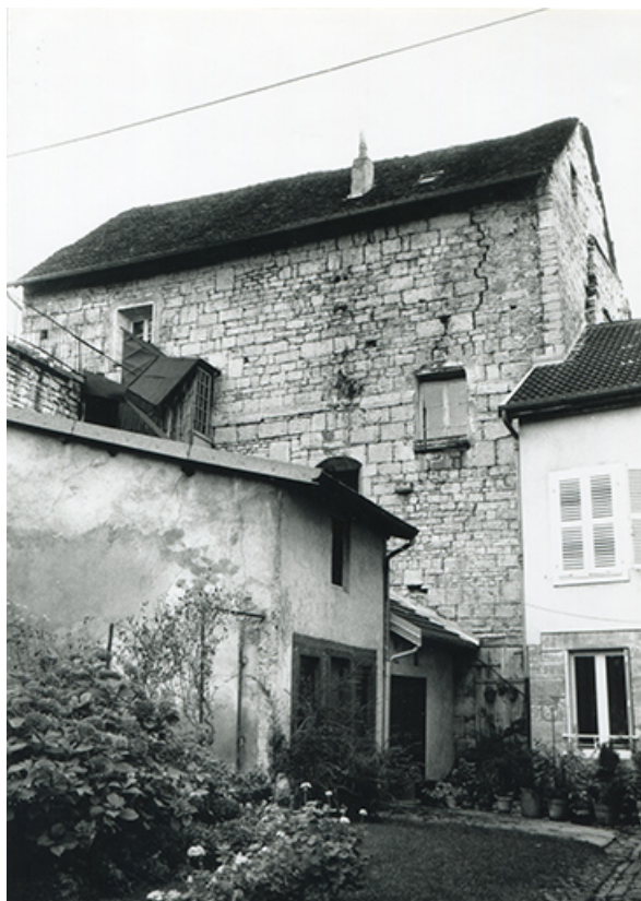
Façade nord de la chapelle, 1990.
