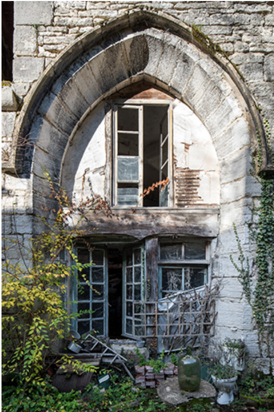
Fenêtre à arc brisé du chevet.
