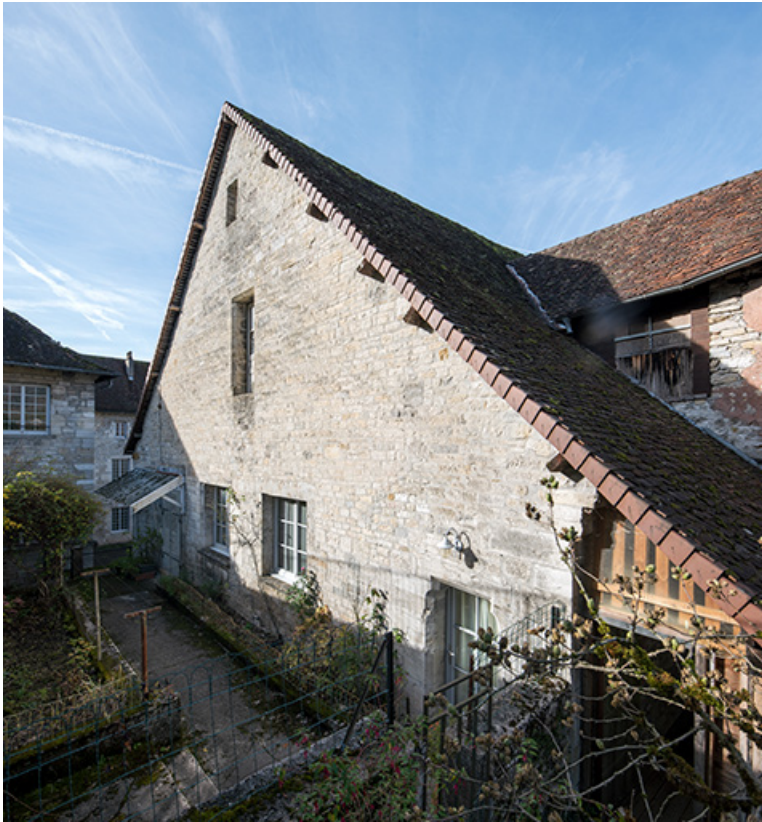
Mur-pignon est de la maison du Temple.
