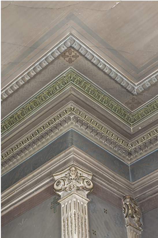
Détail des corniches du chœur.
