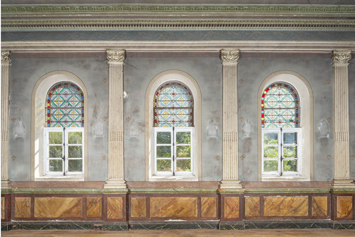
Façade est de la chapelle.
