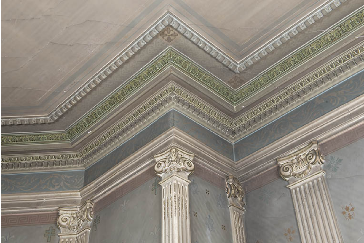
Détail des corniches du chœur.
