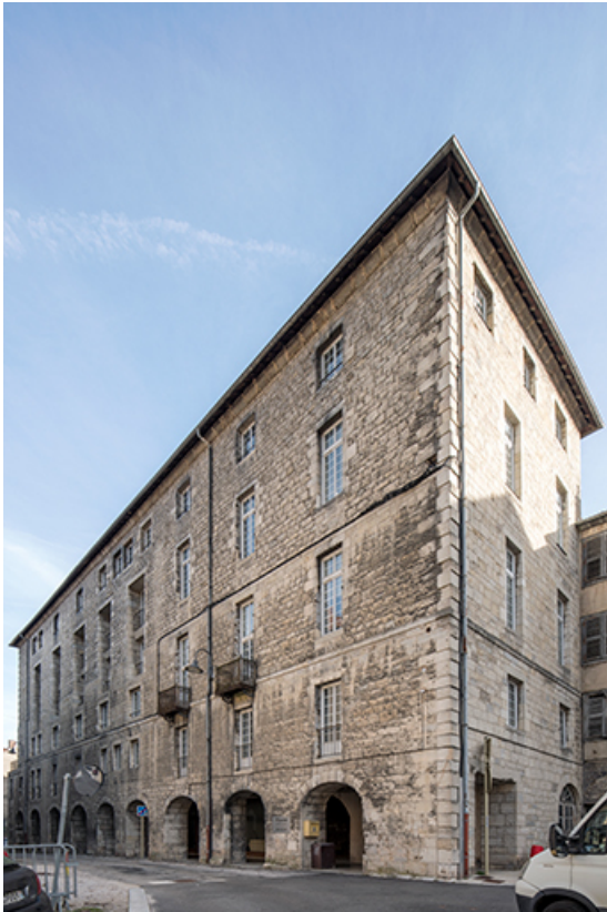
Elévation sur rue depuis le sud-ouest.
