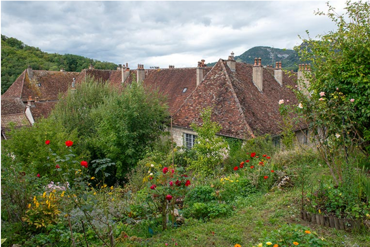
Toitures du couvent, depuis le sud-est.
