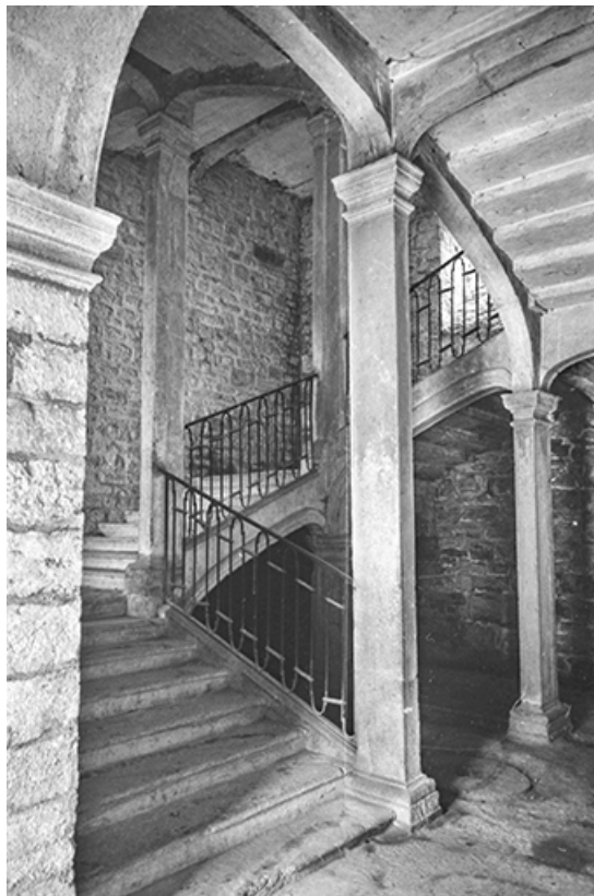
Grand escalier, s.d. [vers 1960].
