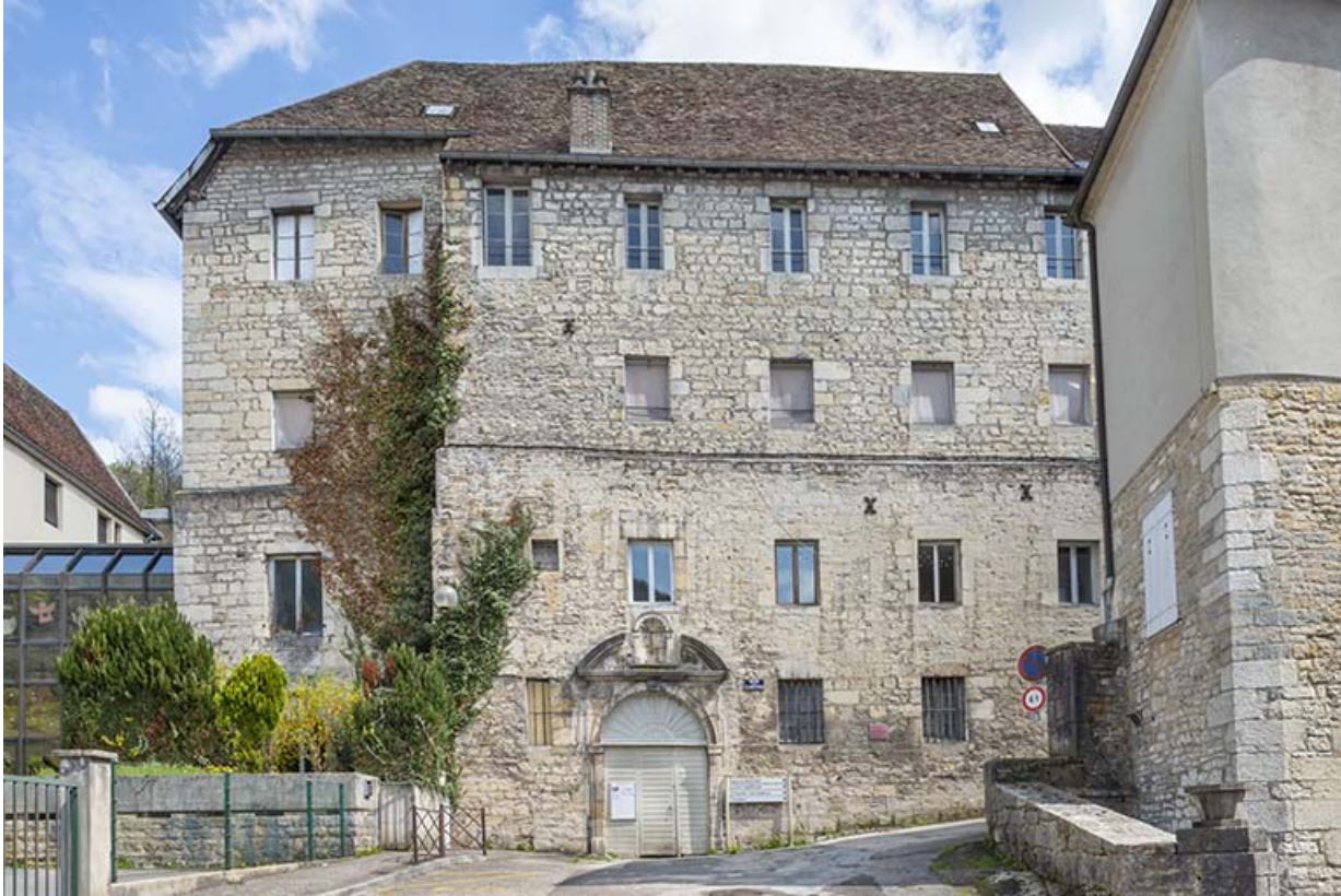
Extrémité nord du bâtiment, depuis l'ouest.
