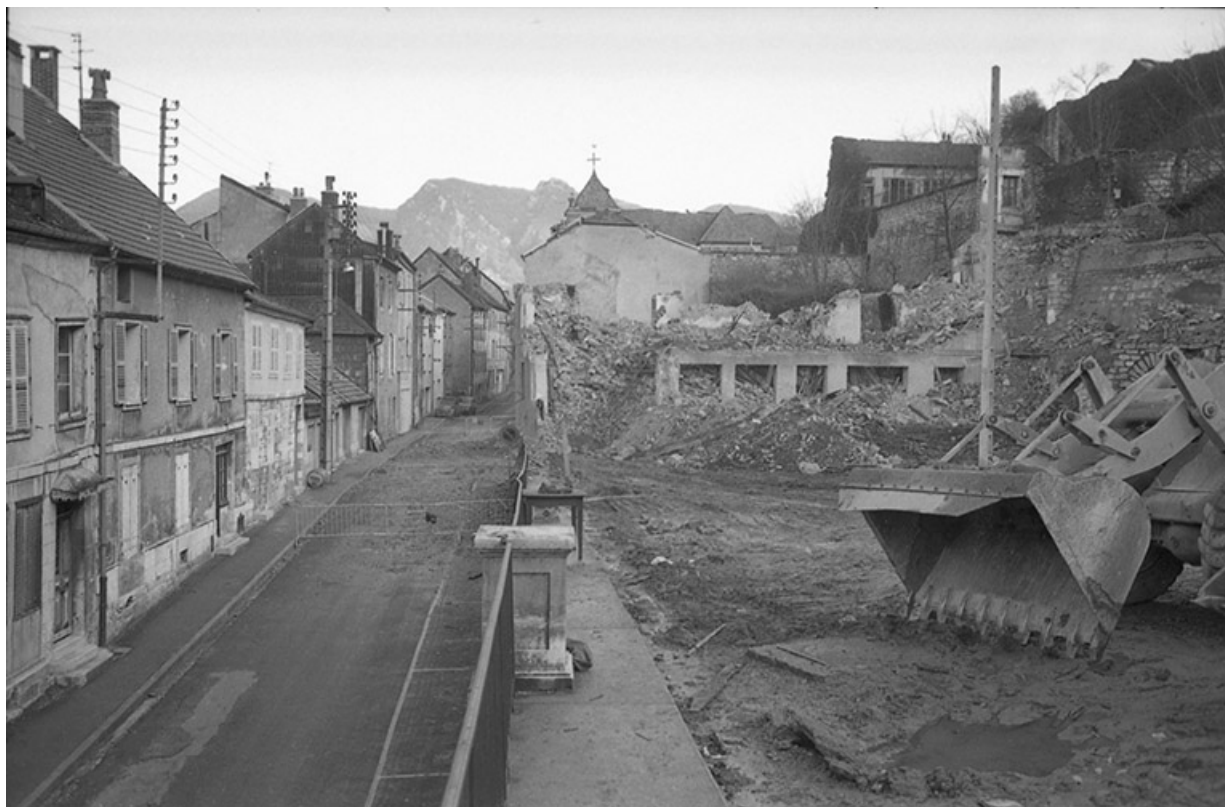
Démolition des bâtiments, vers 1973.
