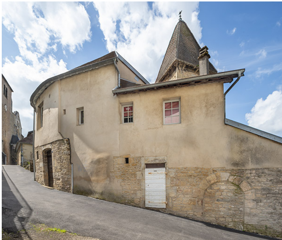
Façade nord, depuis la ruelle d'Arçon.
