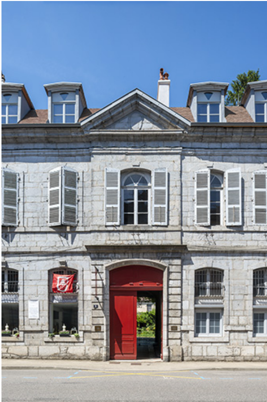
Façade antérieure. Travées centrales.
