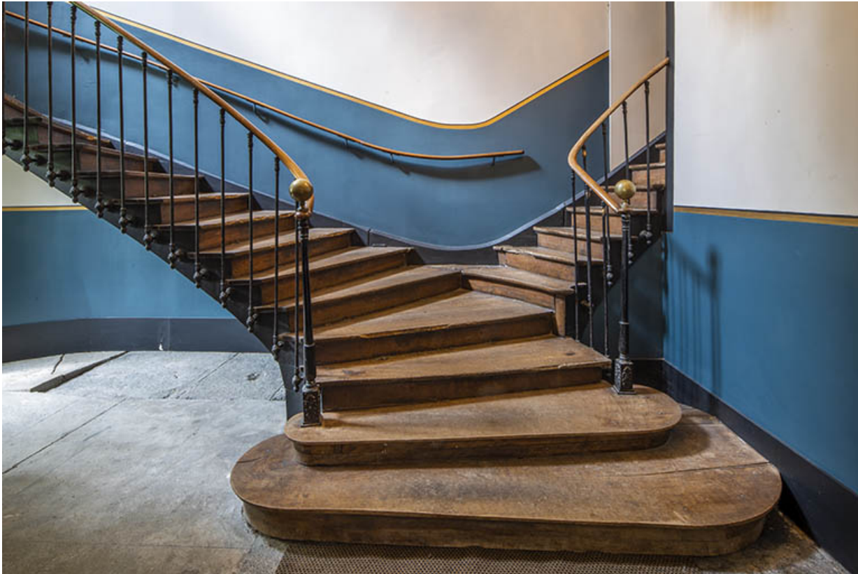
Départ de l'escalier (aile nord).
