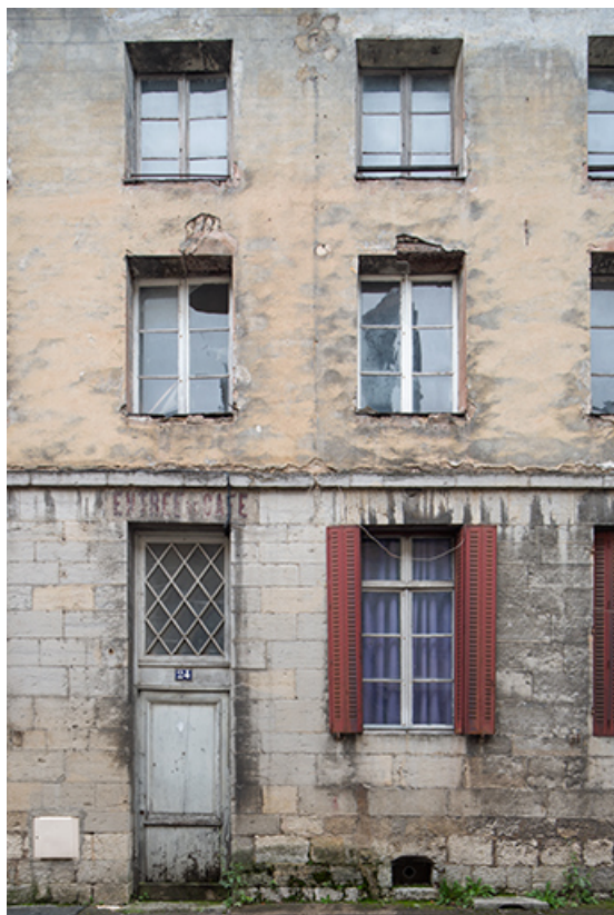
Travées centrales de la façade postérieure.
