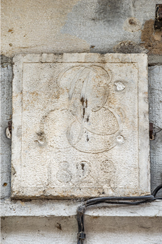
Rez-de-chaussée de la façade. Plaque gravée.
