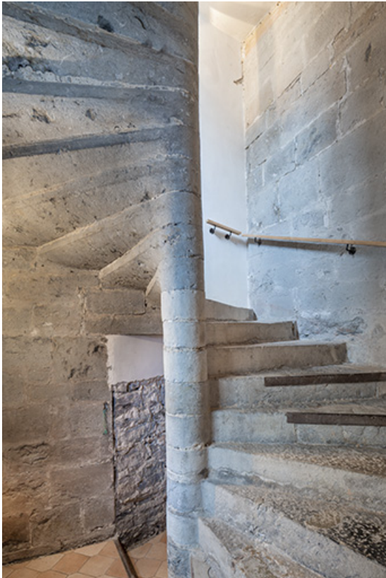
Escalier en vis (bâtiment sur rue).
