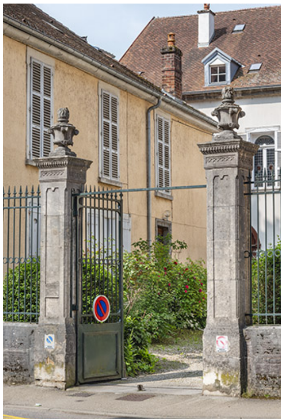
Porte d'entrée de la cour.
