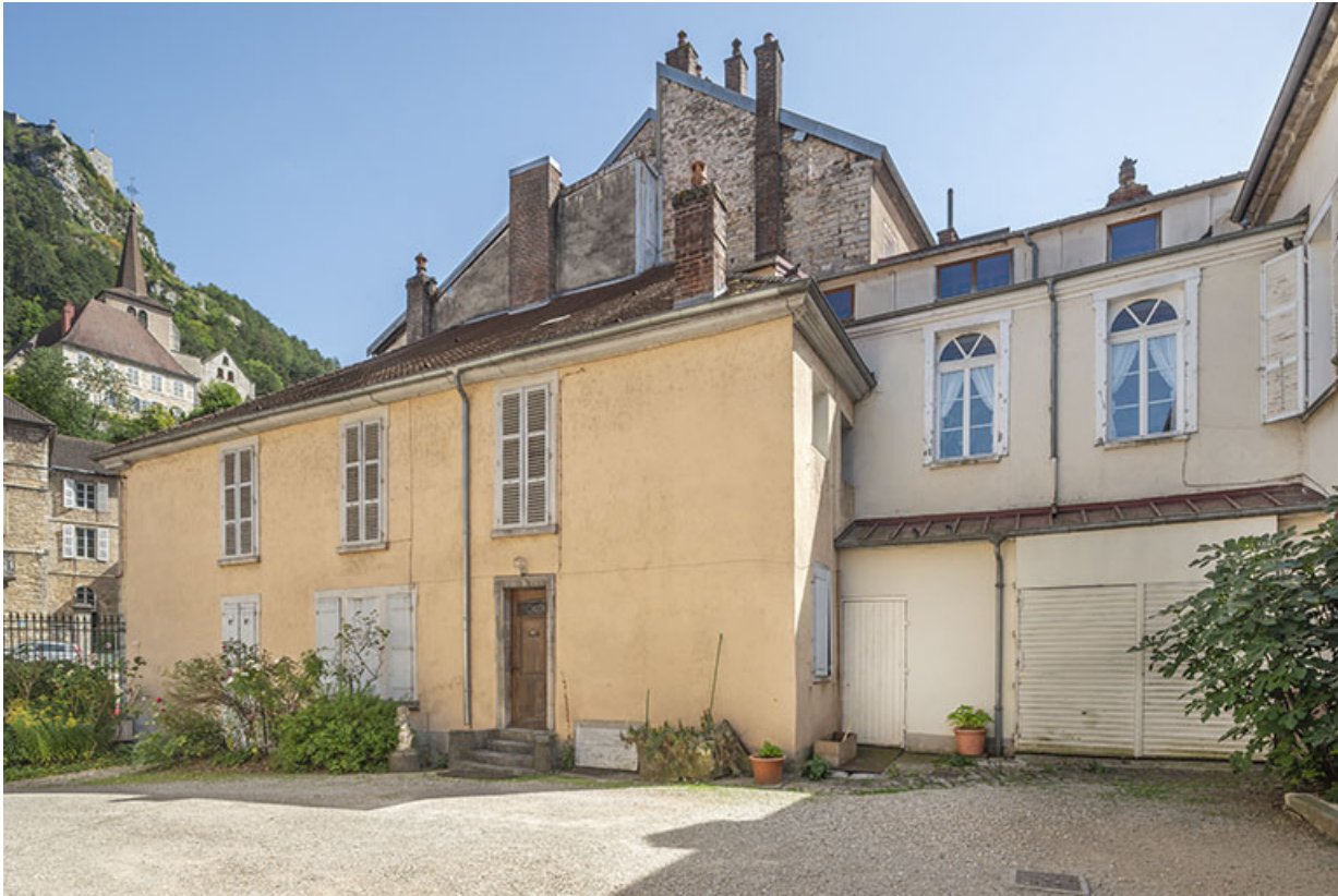
Pavillon sud. Vue de trois quarts.
