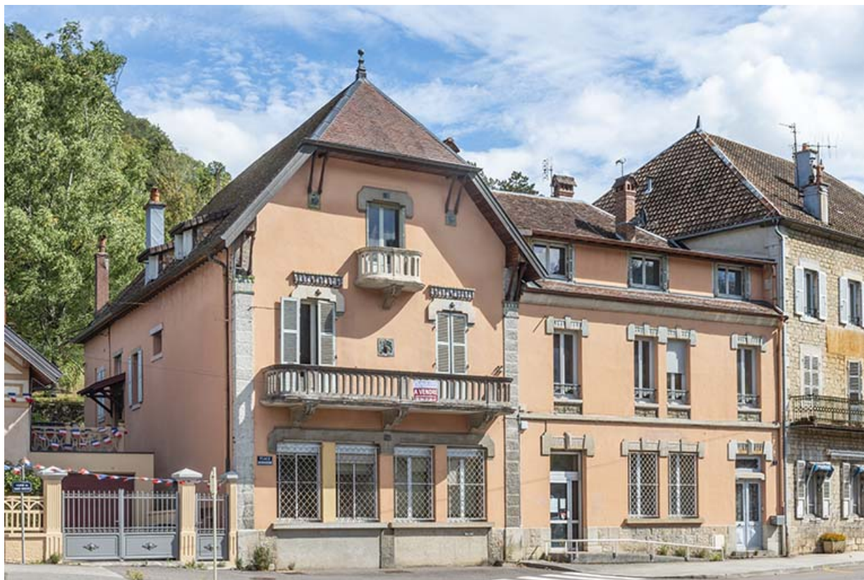
Partie nord vue de trois quarts.
