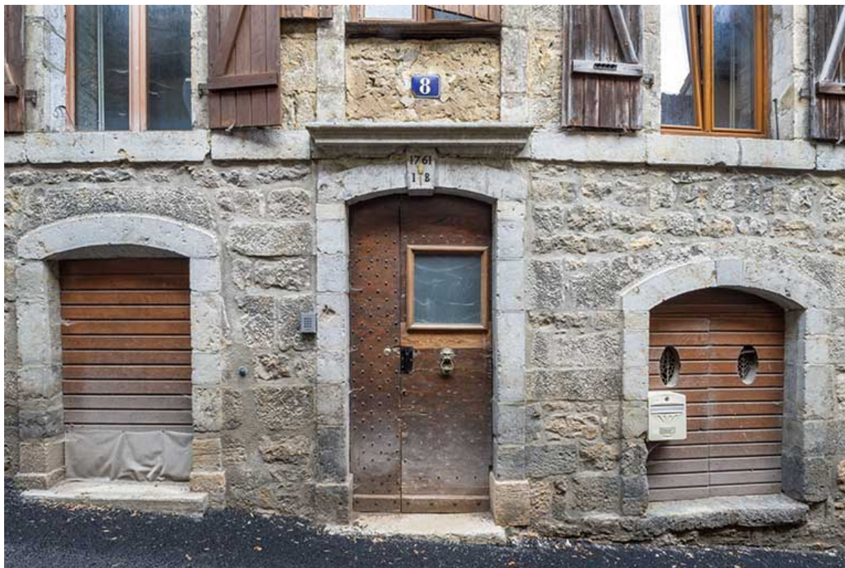
Travées encadrant la porte principale.
