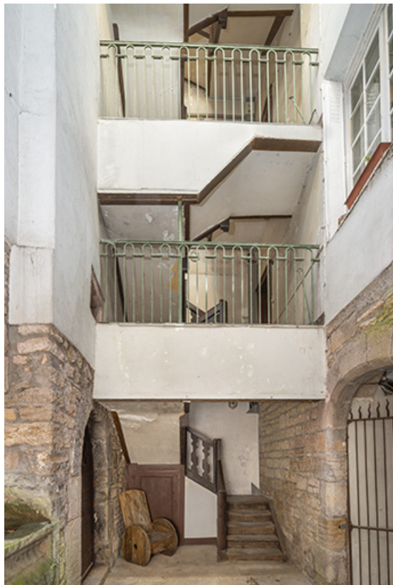
Cage d'escalier au sud de la cour.
