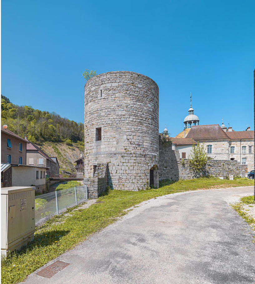
Vue depuis le sud.
