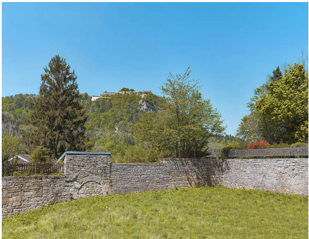
Rempart est, et poterne (murée) de Châtelguyon.
