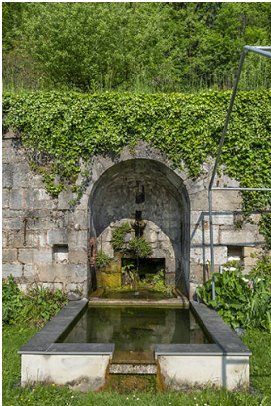
Fontaine dans la cours, au sud.
