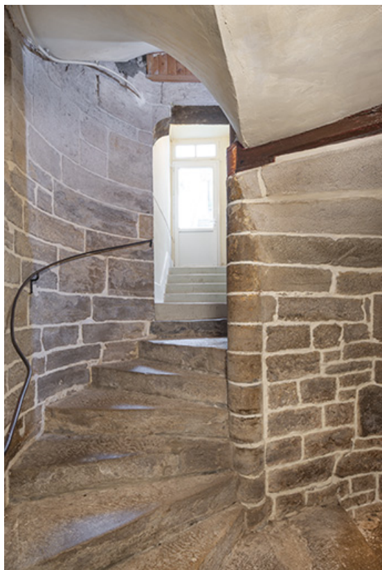
Escalier en vis (premier étage).
