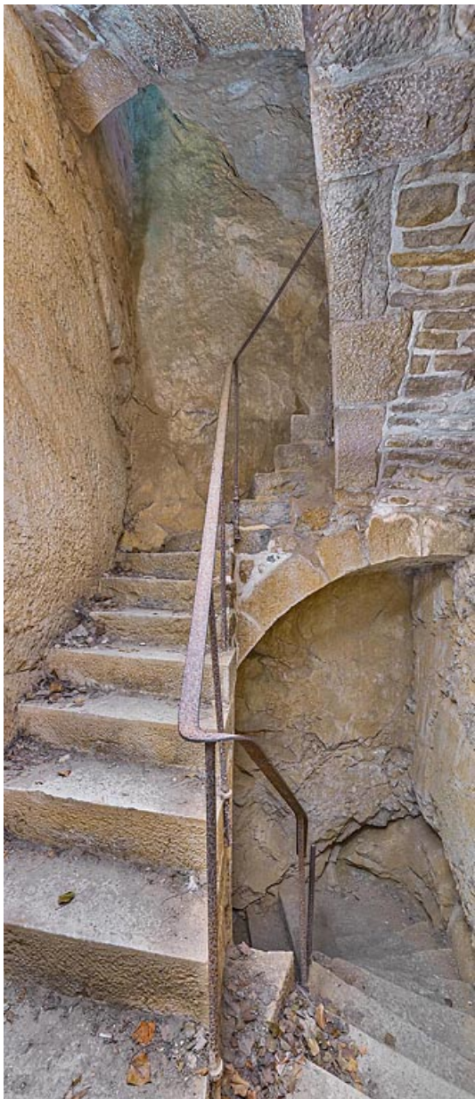
Escalier desservant les étages inférieurs.
