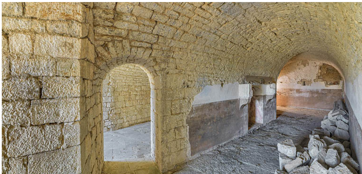
Salle casematée de l'étage avec cheminée.
