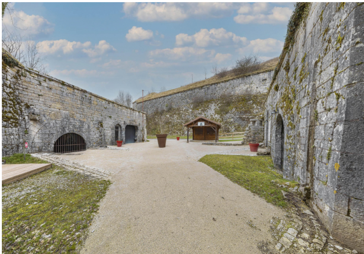
Vue de la cour intérieure.
