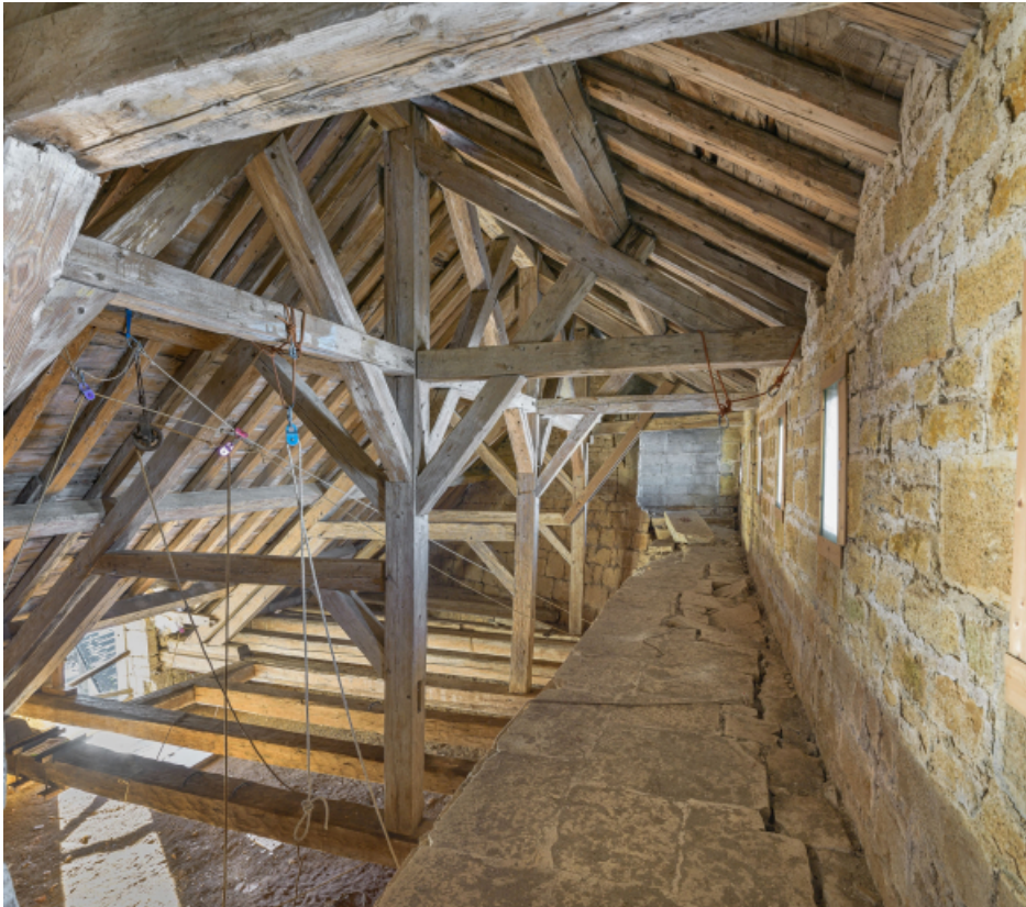
2e étage : charpente du bâtiment.
