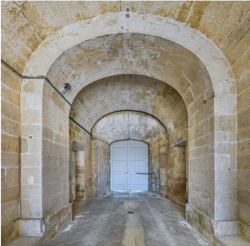
Pavillon d'entrée : passage voûté.
