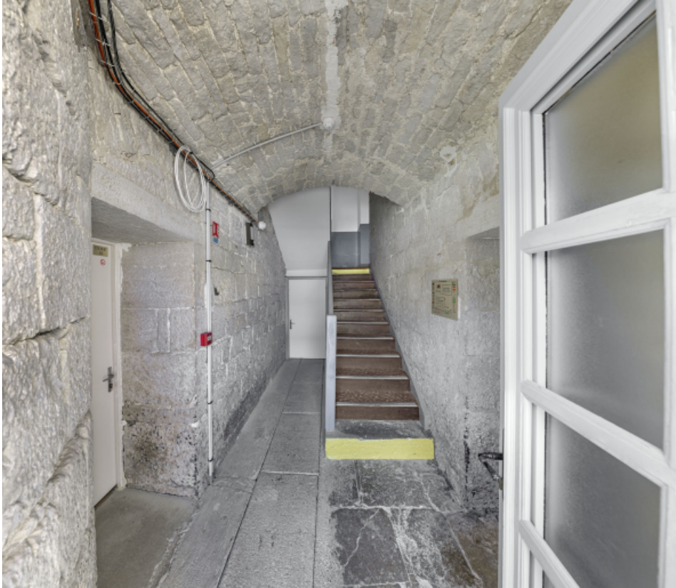
Caserne U, rez-de-chaussée : cage d'escalier.
