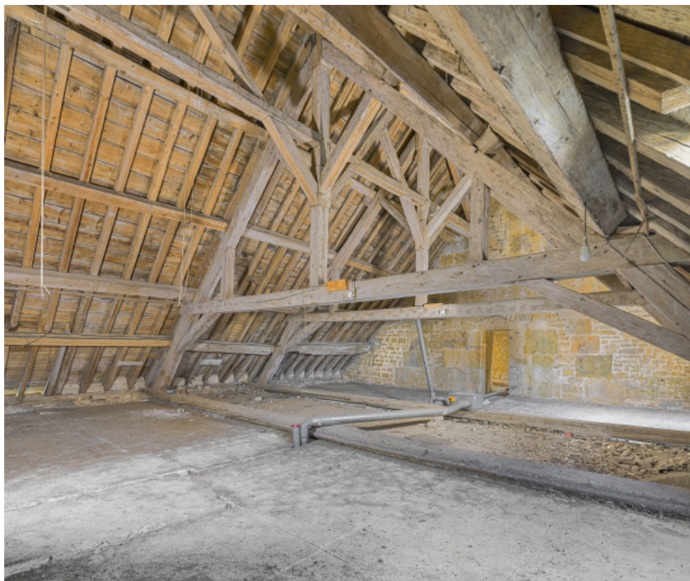
Caserne U, grenier : charpente du bâtiment.
