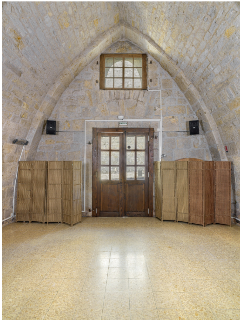
Vue intérieure depuis le mur postérieur.
