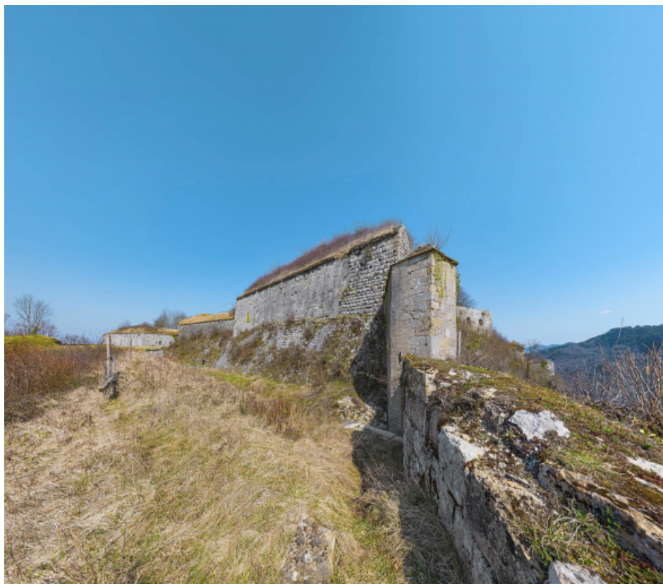
Remparts : angle sud-est.
