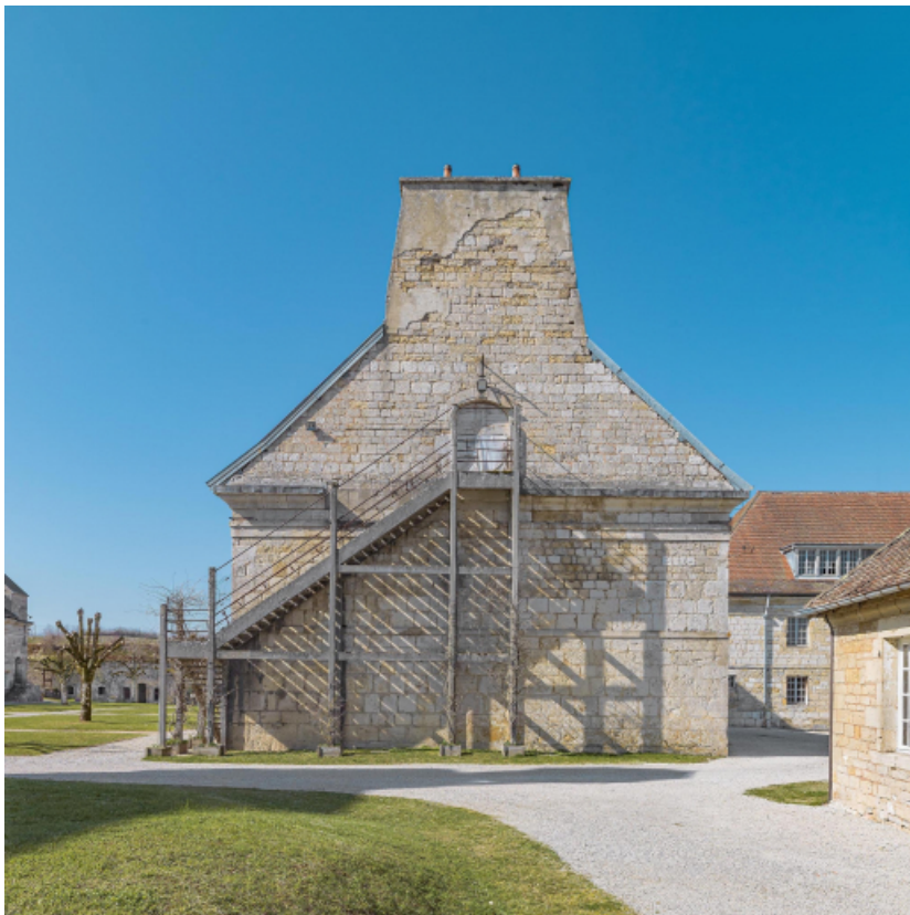
Caserne U : mur pignon est.
