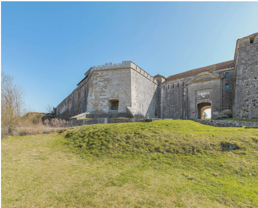
Les bastions encadrant l'entrée principale du fort.
