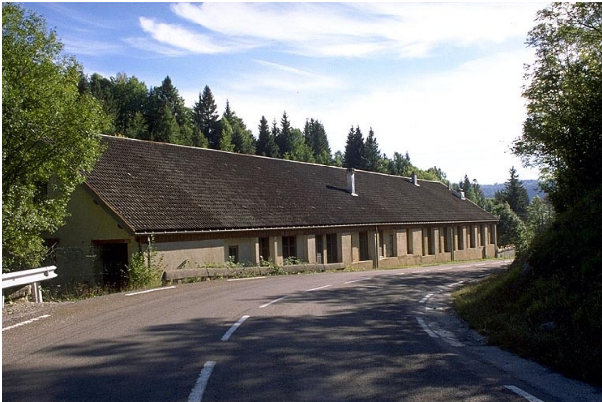
Façade ouest de l'atelier de fabrication.
