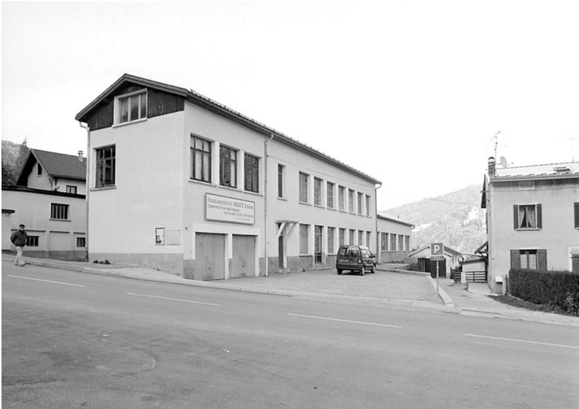
Vue d'ensemble depuis le sud : élévation antérieure.
