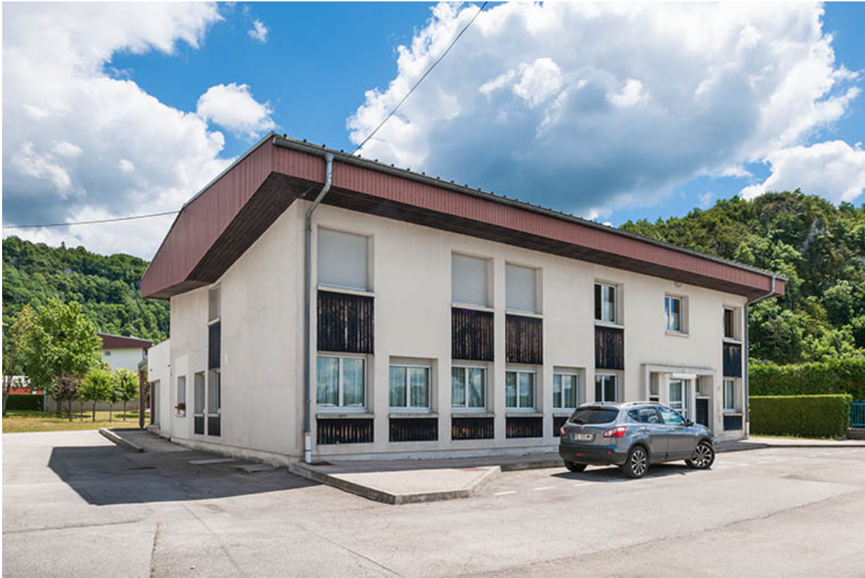
Administration, façade postérieure.
