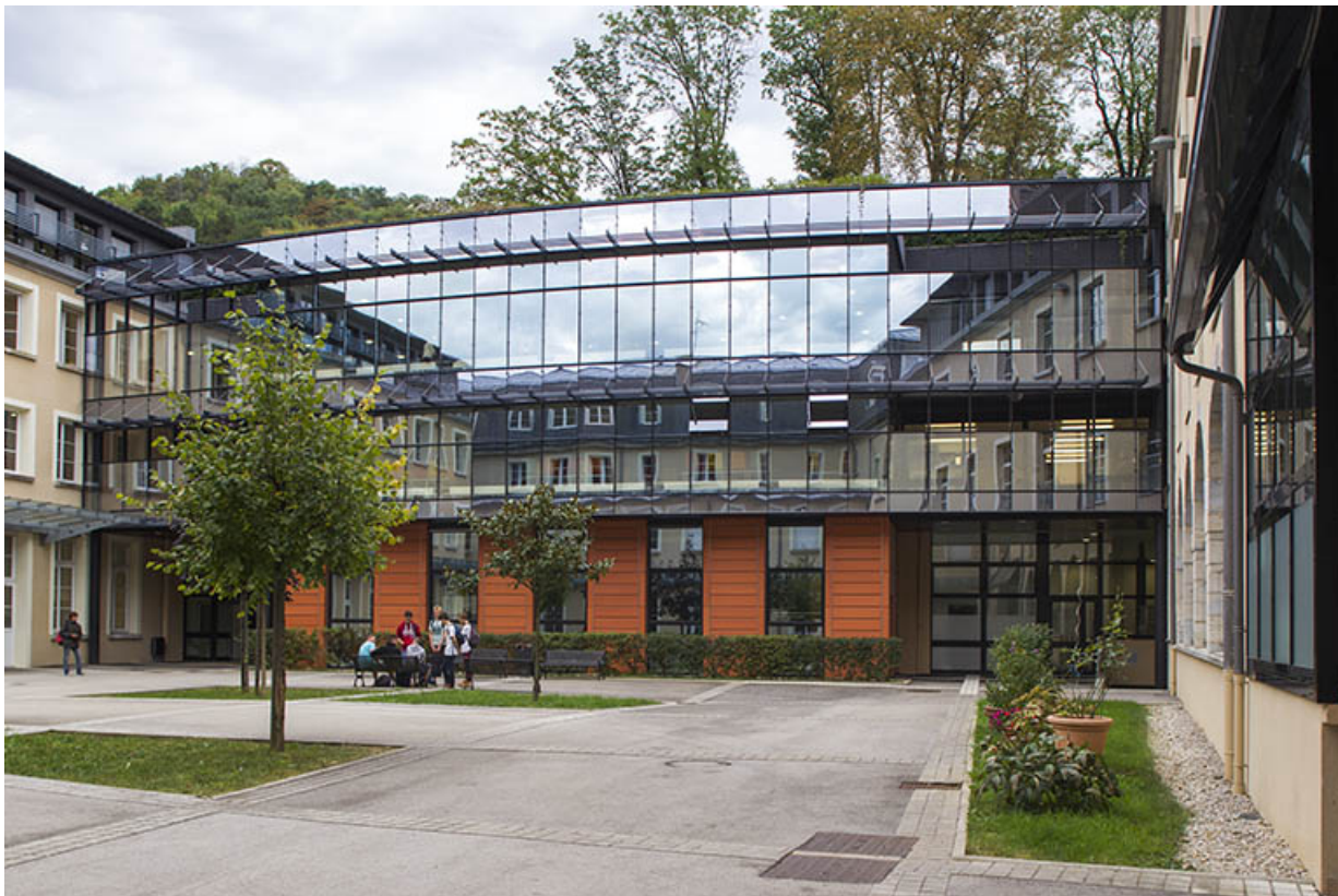
Aile Est : façade antérieure sur cour.
