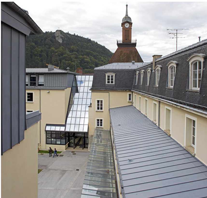
Aile Ouest : toitures at auvents.
