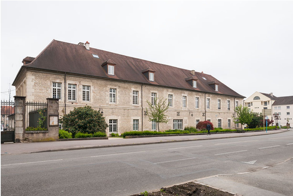
Atelier-externat : façade sur la rue des Arènes.
