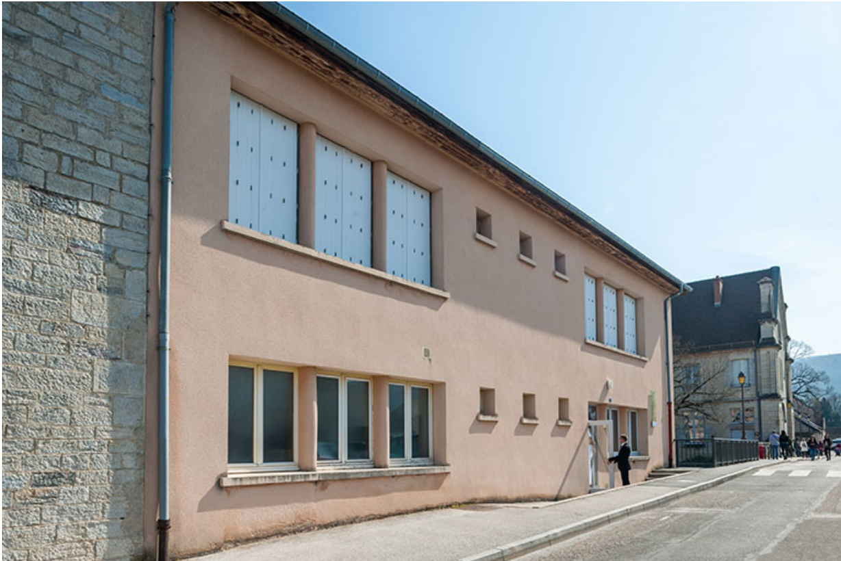
Annexe : façade antérieure, vue trois-quart.
