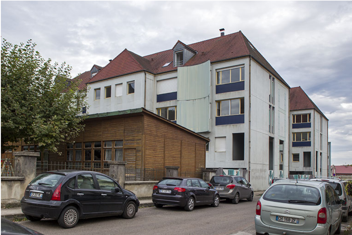
Internat : façades arrière.
