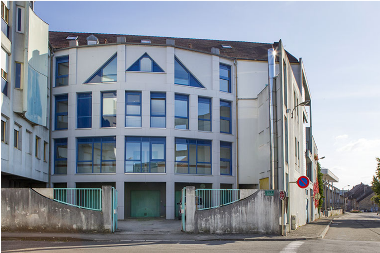
Internat : façades avec jeu des avant-corps.
