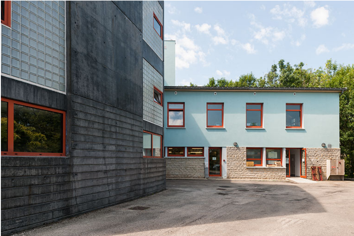
Internat : aile ouest.
