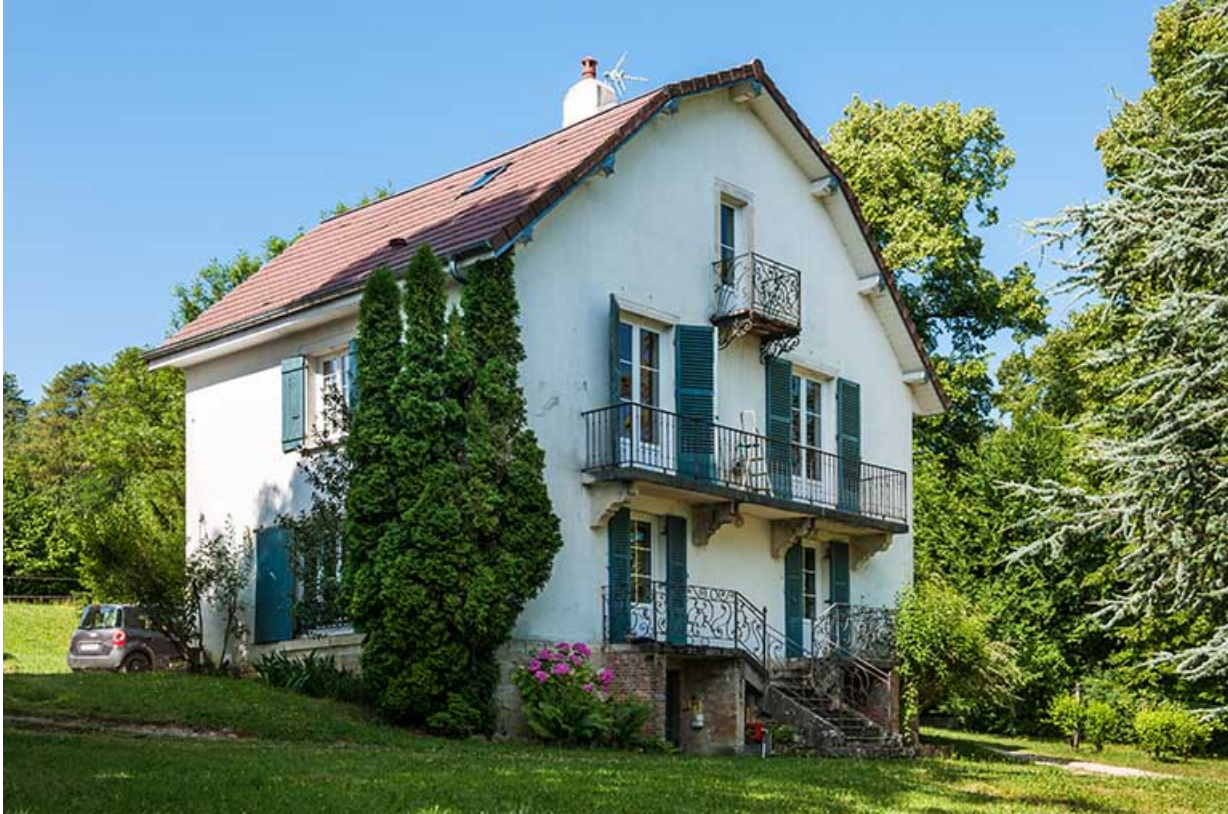
Pavillon du proviseur, vue trois quart.
