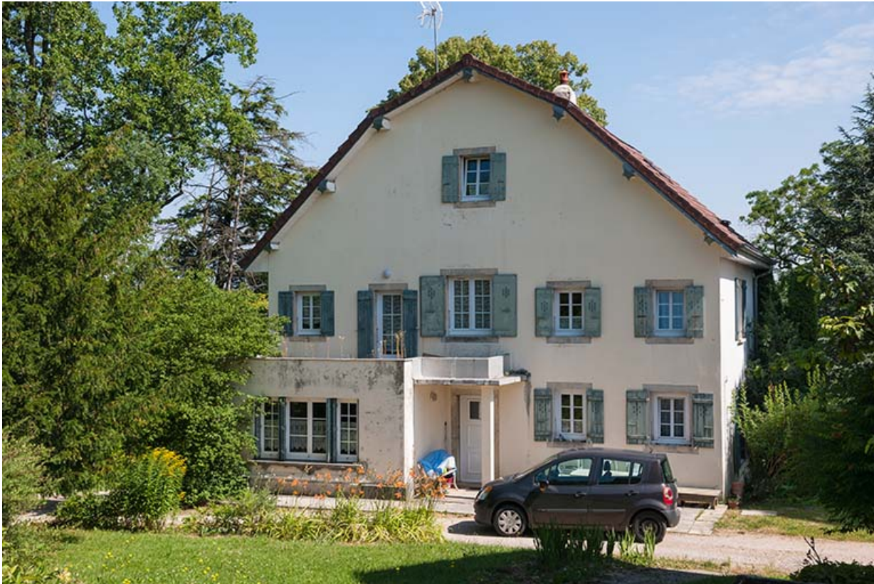
Pavillon du proviseur : façade postérieure.
