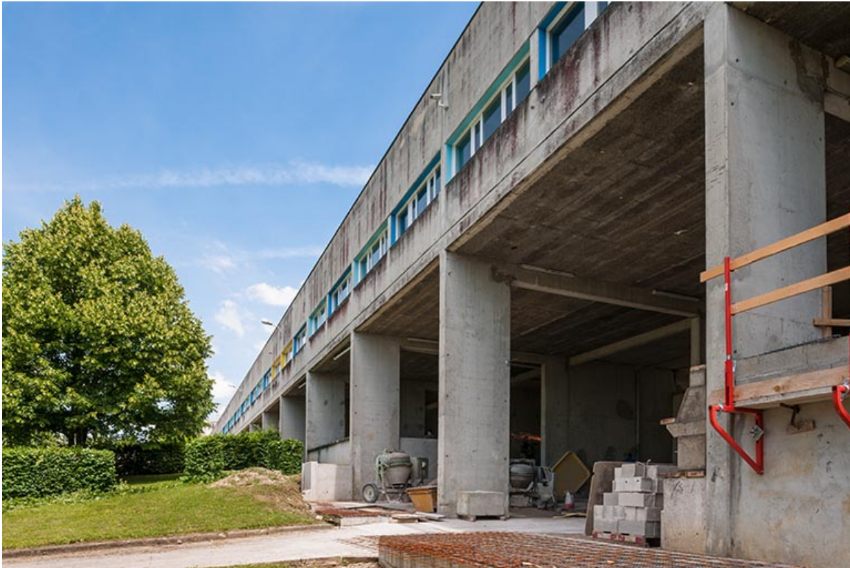
Externat : façade postérieure.
