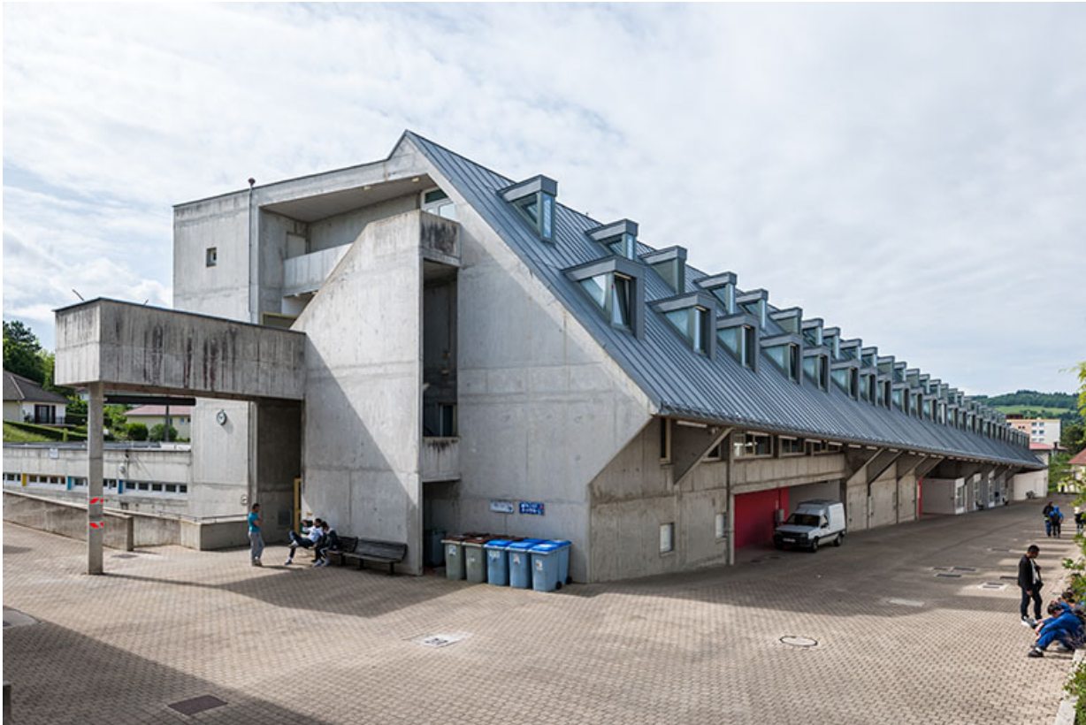
Façades et pignon nord du bâtiment internat-administration.
