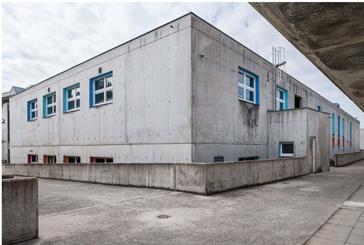
Atelier métal : façade latérale.
