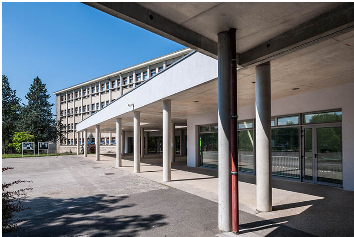
Liaison entre bâtiments : détail.
