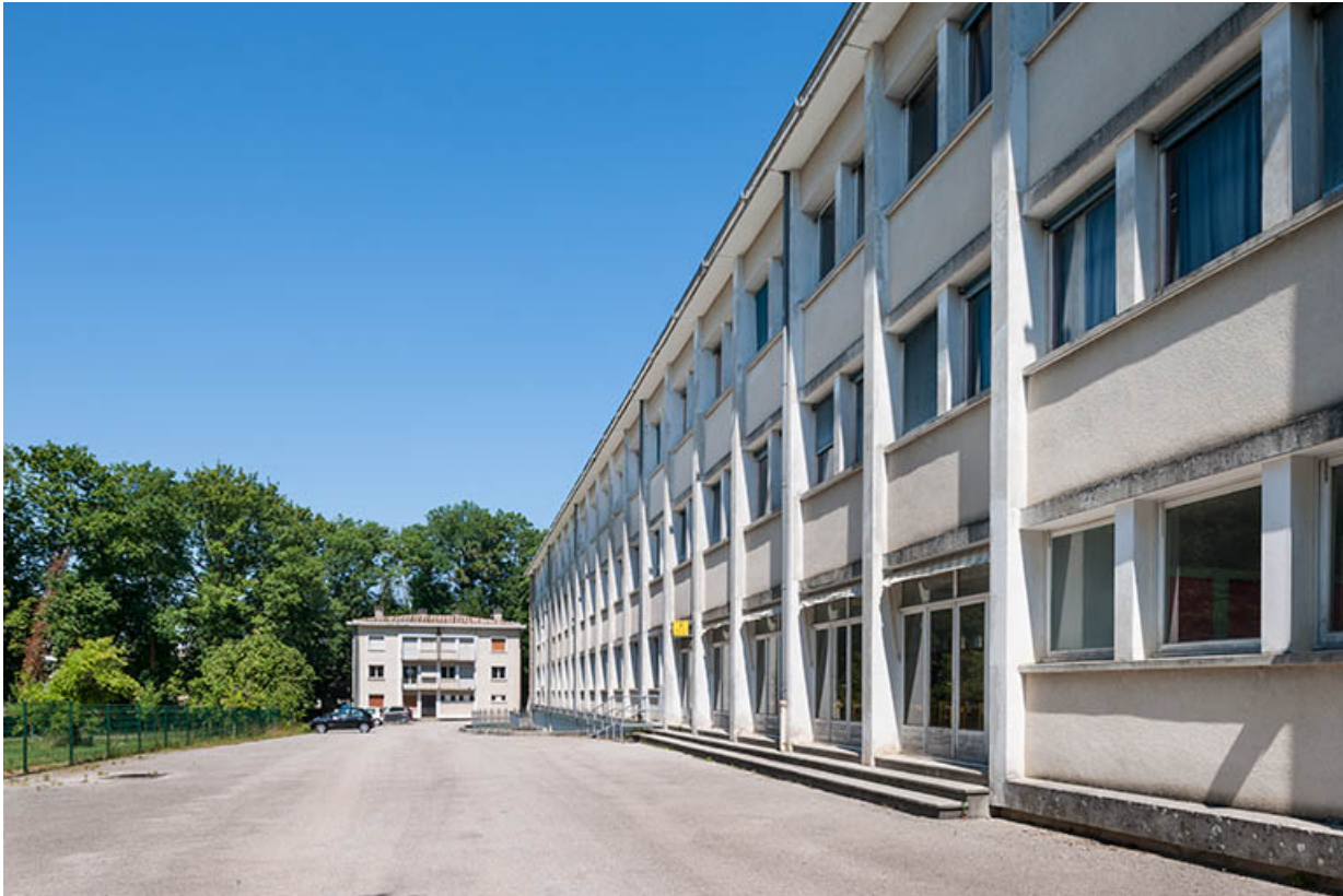
Façade de l'externat, en arrière-plan logements.
