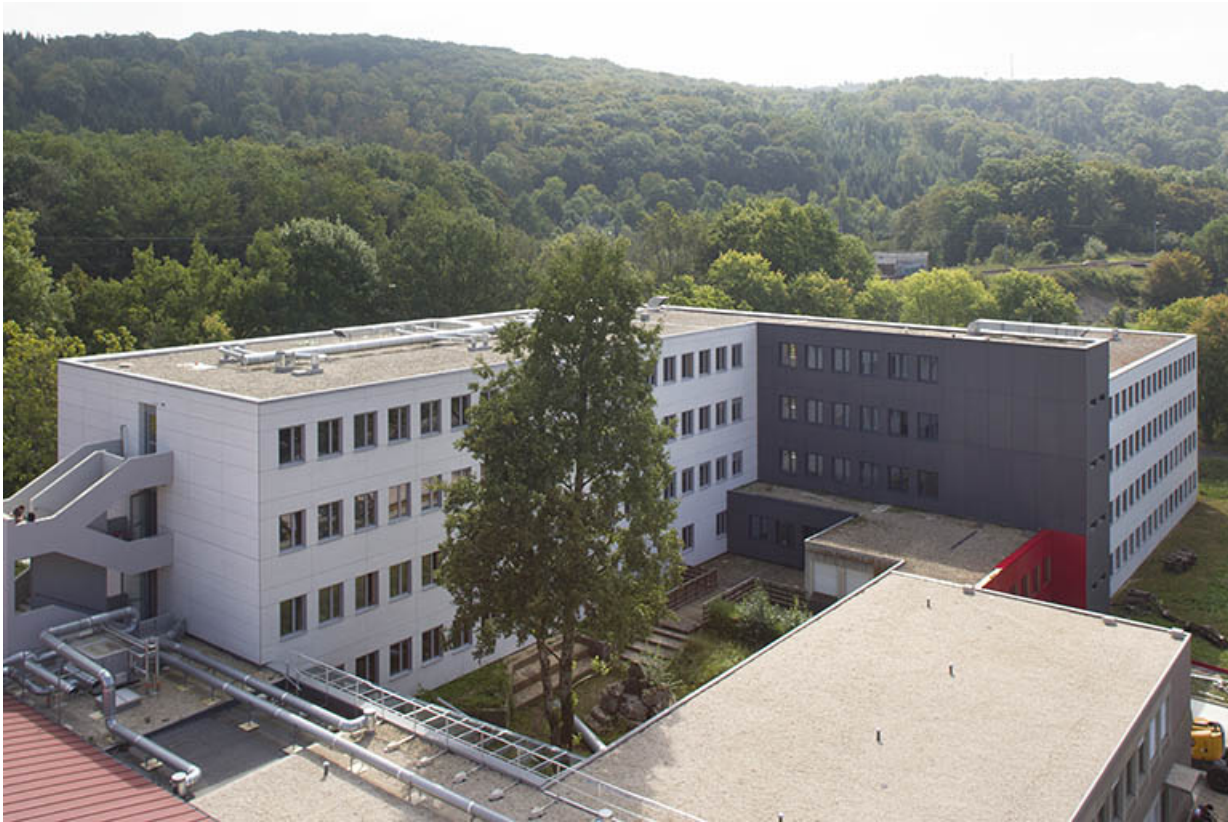
Internat : vue générale après restauration des façades.
