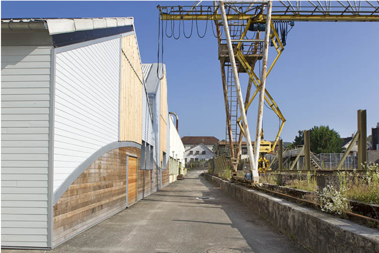
Atelier : façade antérieure et détail pont roulant.
