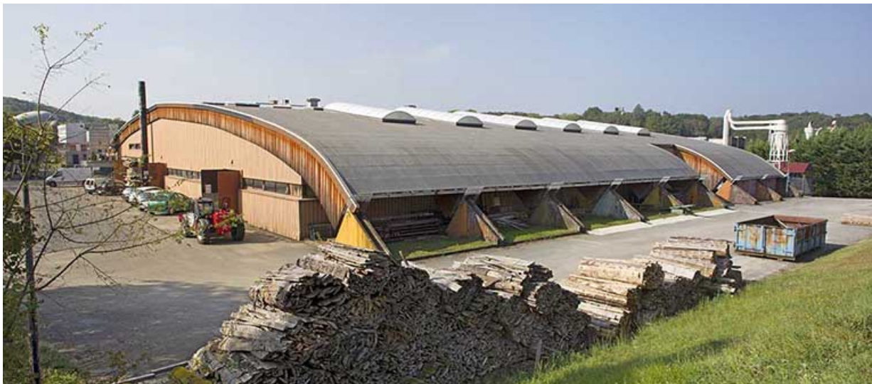
Atelier : couverture avec charpente en lamellé collé.
