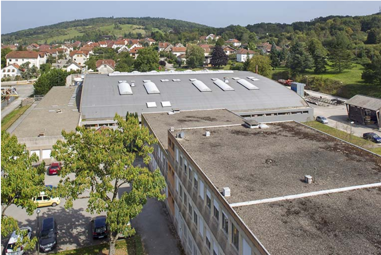
Externat et ateliers scierie et menuiserie : toitures.
