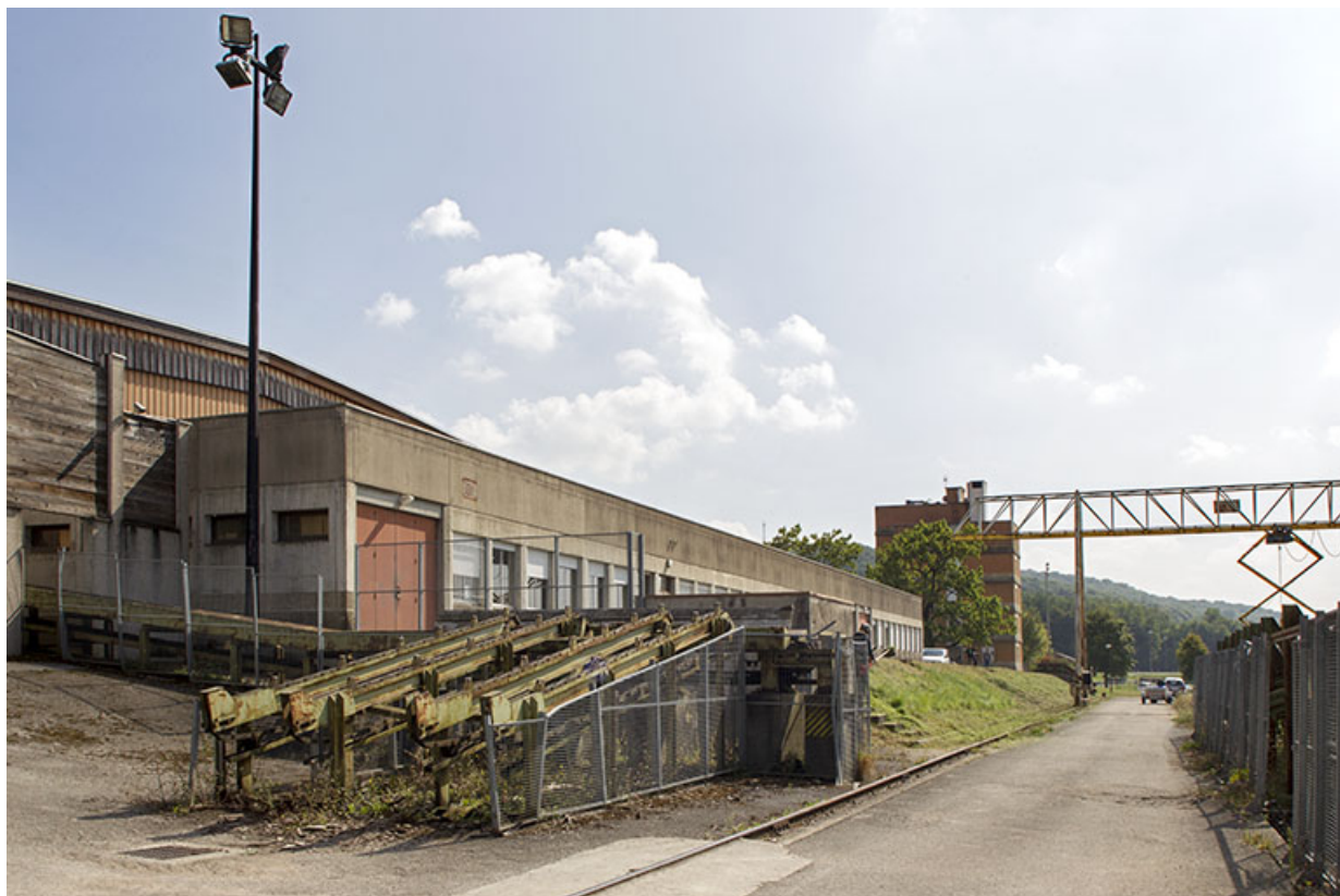
Atelier : façades ouest.
