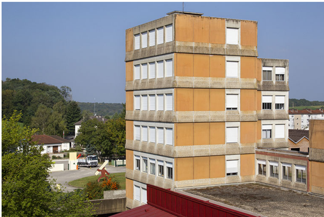
Administration et logements : façades Sud et Est.
