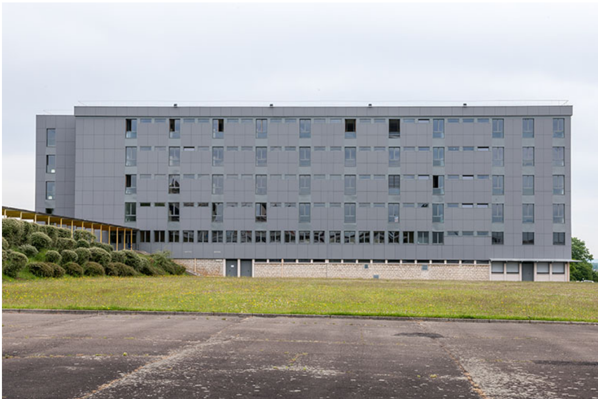
Internat : façade antérieure.
