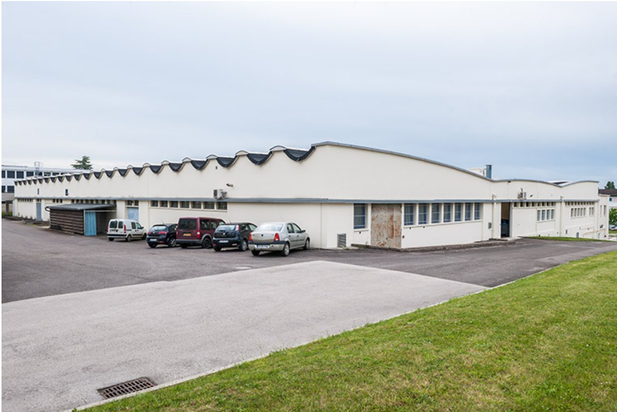
Ateliers : vue générale des façades arrière.
