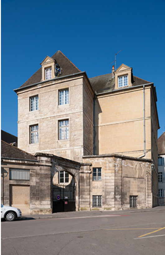
Externat : entrée, rue des Boucheries.
