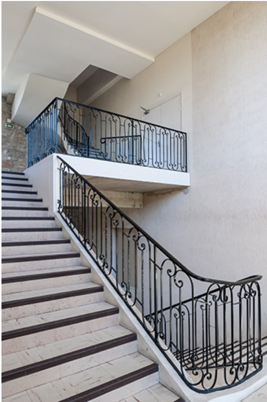
Internat, escalier intérieur.
