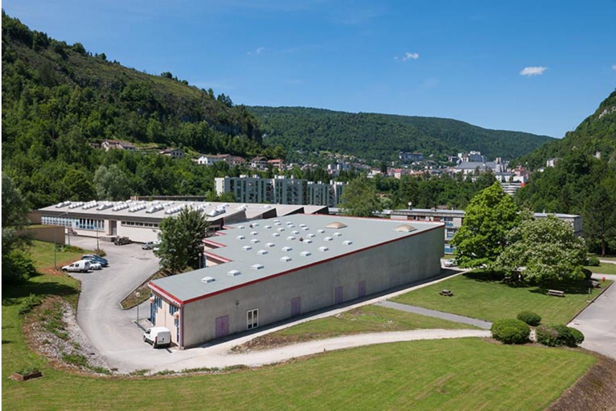
Ateliers : vue d'ensemble des toitures.
