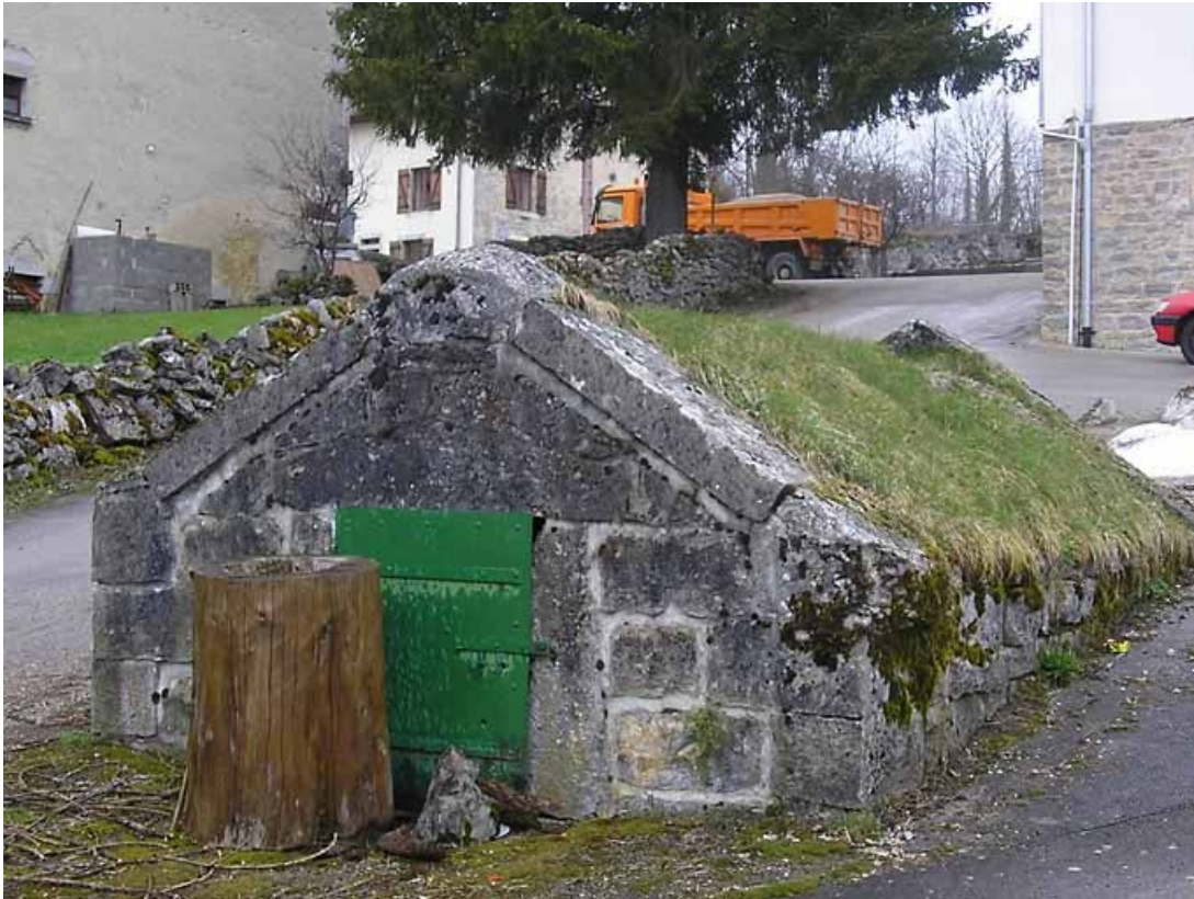
Vue de trois quarts sur ensemble hydraulique.
