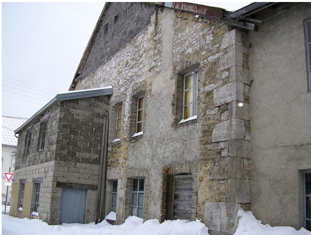
Façade nord-est et appentis.
