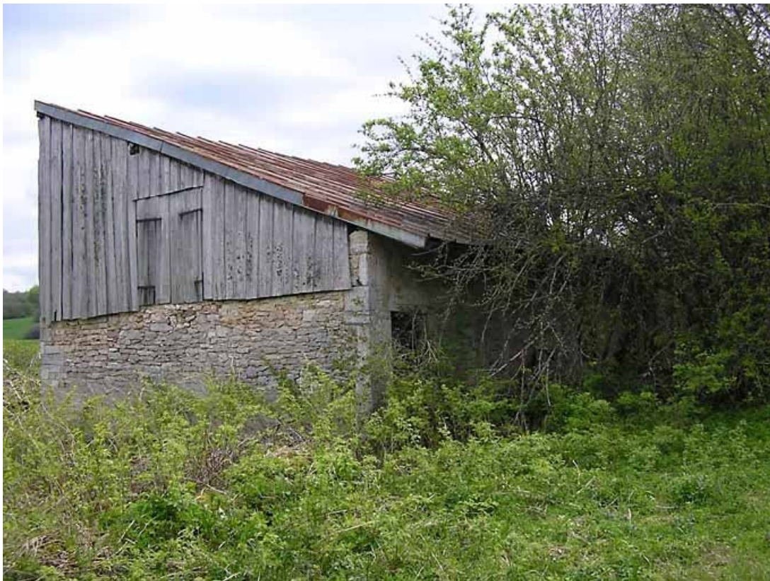
Vue générale du pignon nord-est.
