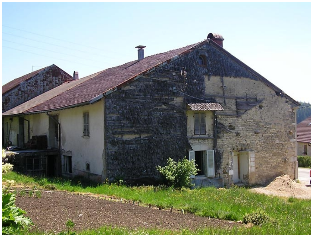
Pignon sud-ouest vu de trois quarts.
