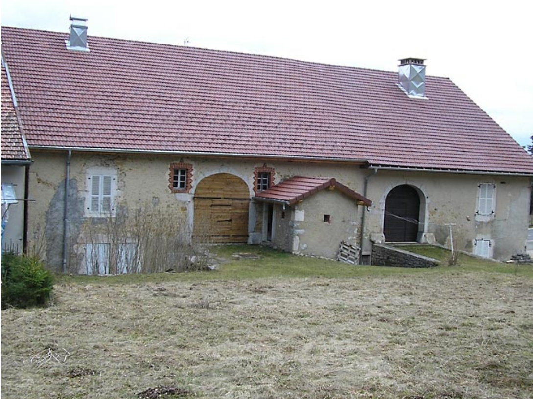
Façade postérieure et ponts de grange.
