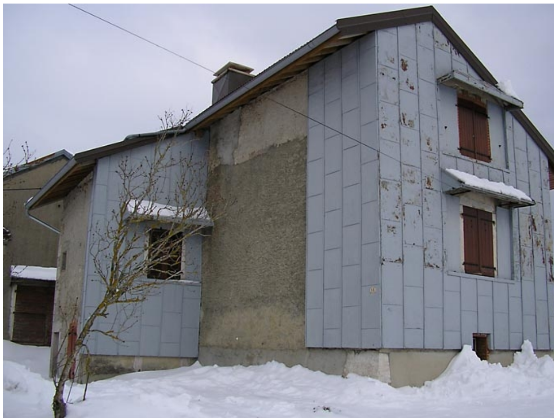
Vue du pignon sud-ouest.
