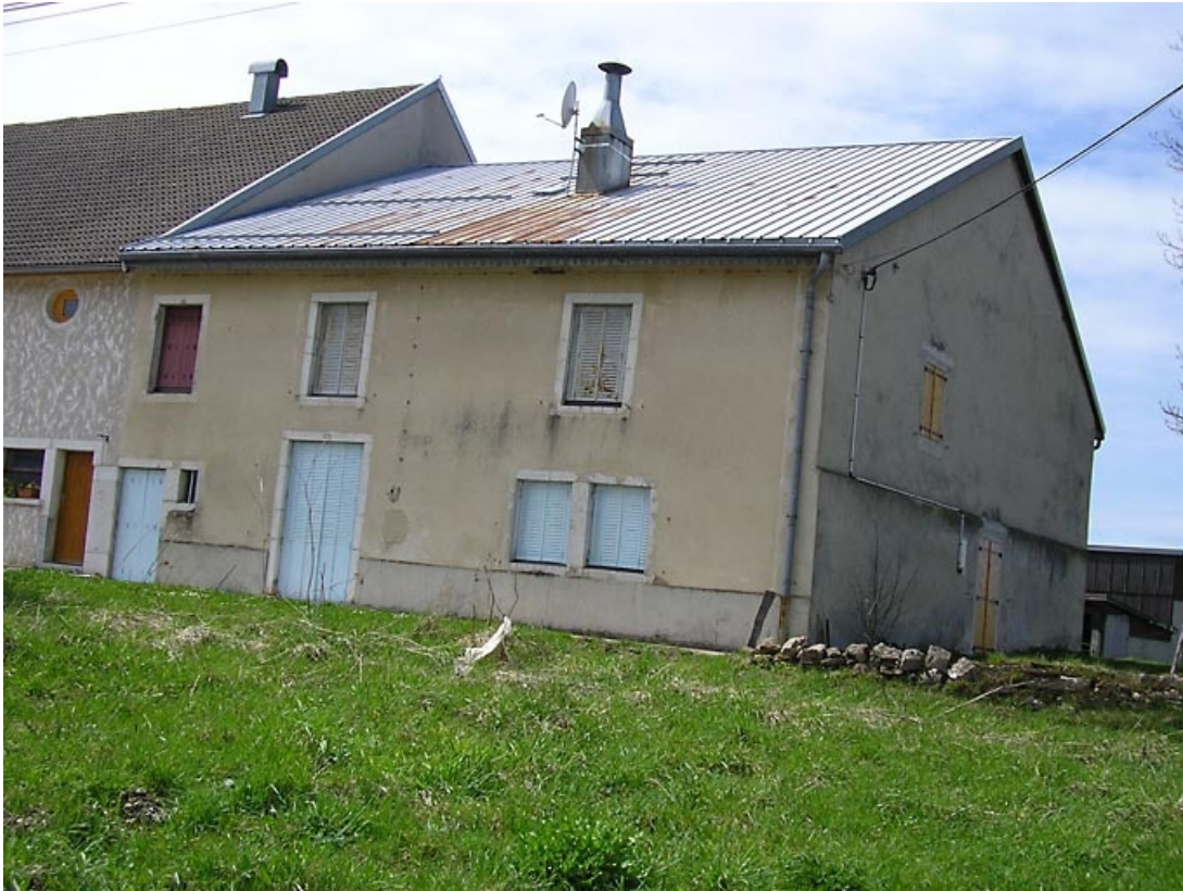
Façade postérieure et pignon sud-ouest.
