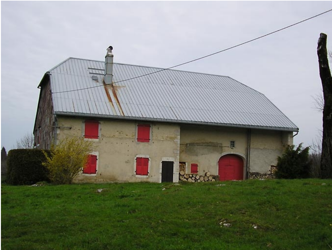
Vue générale de la façade postérieure.
