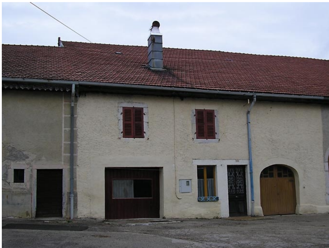
Vue latérale de la façade antérieure.
