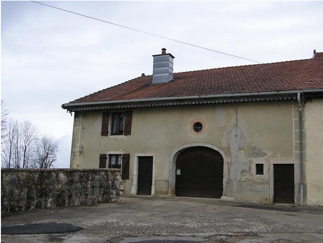
Vue générale de la façade postérieure.
